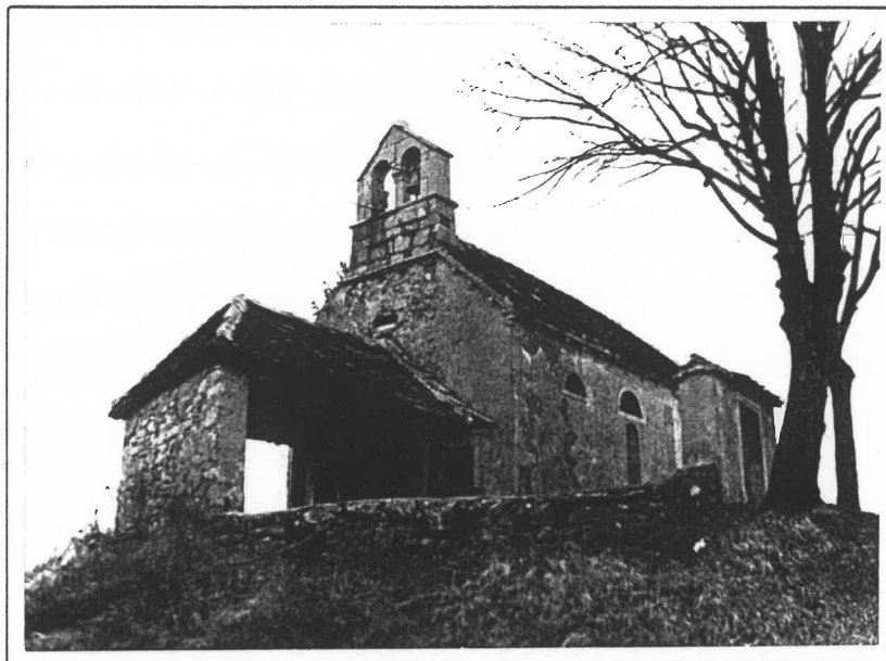
Pogled na južno fasado
