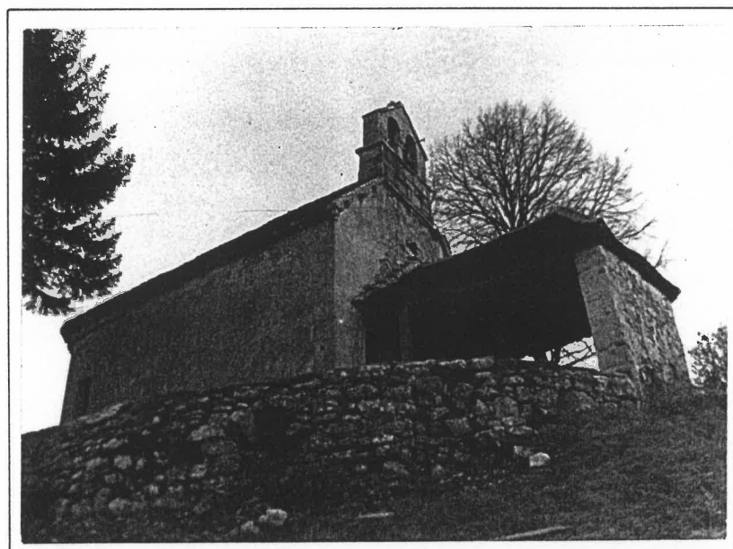
Pogled na severno fasado
